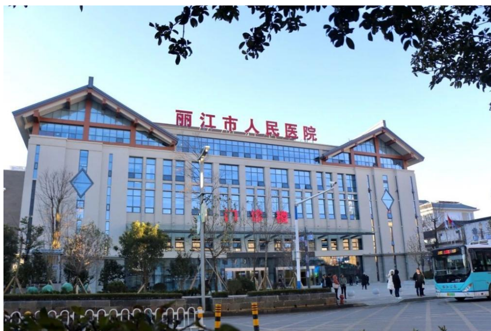
丽江市人民医院福慧院区
